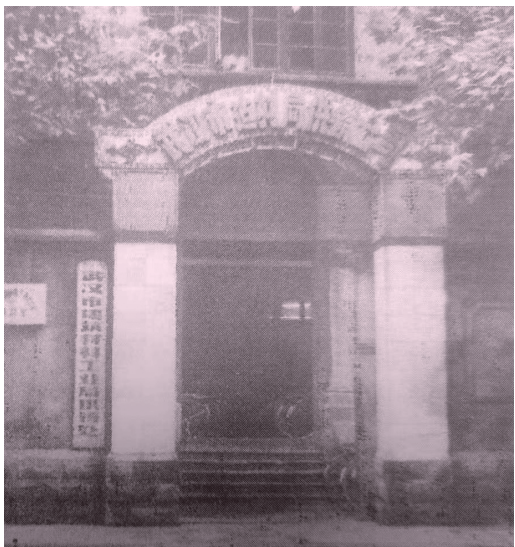
汉口铭新街13号中共中央组织部旧址
